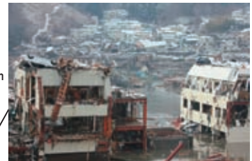
女川町市街地。3階建てのビルの屋上に乗用車が打ち上げられている。
