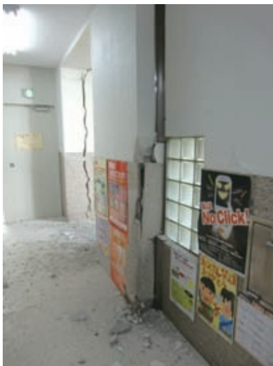
図3 2年生教室前の廊下と柱の亀裂
