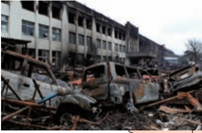
津波後の火災で焼け焦げた石巻市門脇小学校。
