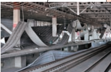
壁が崩壊し、天上が落ちた JR 仙台駅新幹線ホーム
