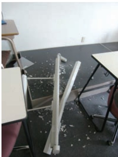
図2 3年生教室の落下した蛍光灯
